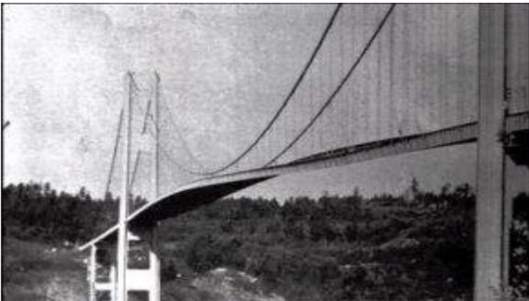
Destruction à cause de la résonance, suite à des oscillations croissantes du tablier dues à la charge des vents.
